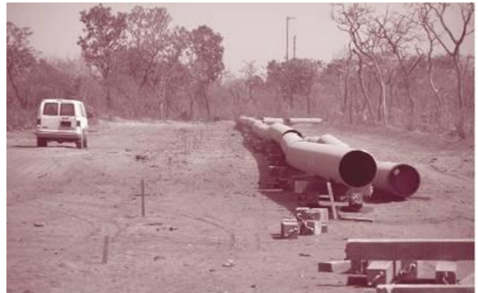
Pipeline construction in Chad © Martin Petry/Brot für die Welt
